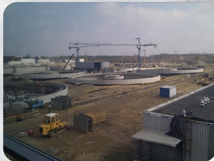
Foto: Budowa oczyszczalni ścieków Czajka w Warszawie
