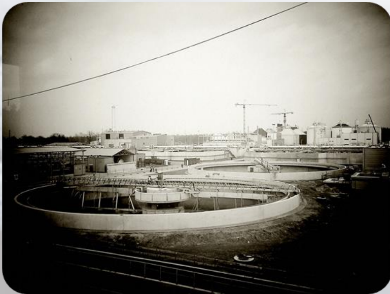
Foto: Oczyszczalnia ścieków Czajka w Warszawie
